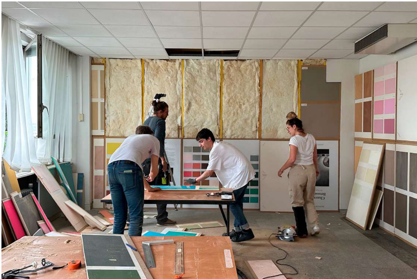
CHANTIER ÉTUDIANT (M2 ENSAT) À LA BOULLONNANTE
