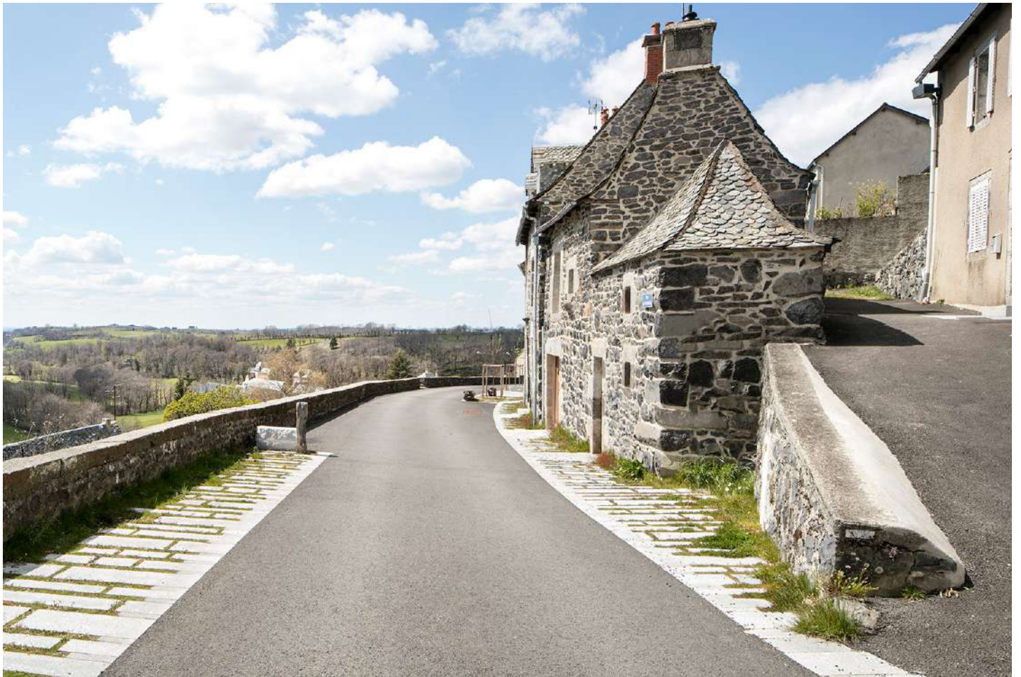
SORTIE DU BOURG, TROTTOIR MIXTE GRANIT/HERBE
