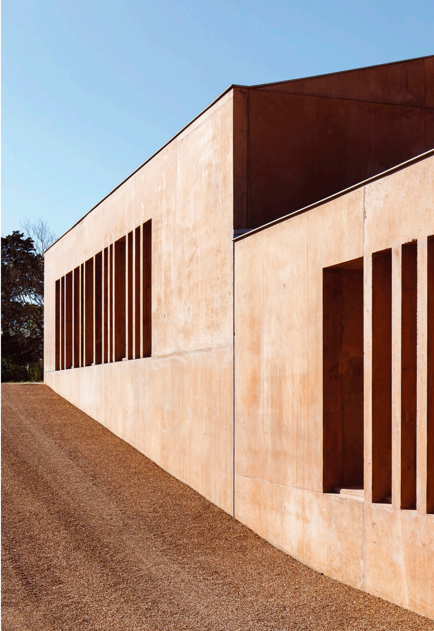
Détail de la façade Sud
