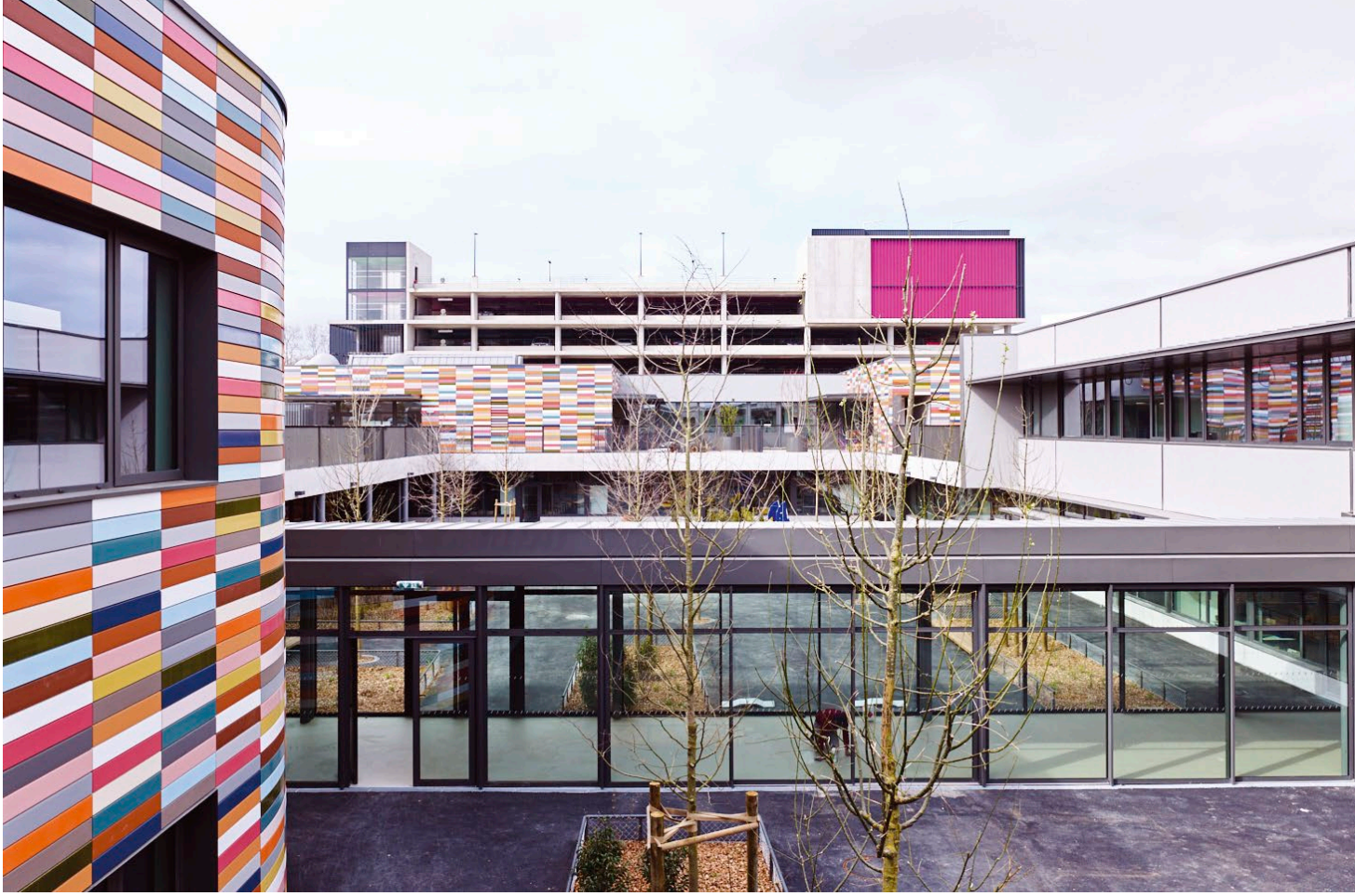
Cours de récréation depuis la passerelle élémentaire
