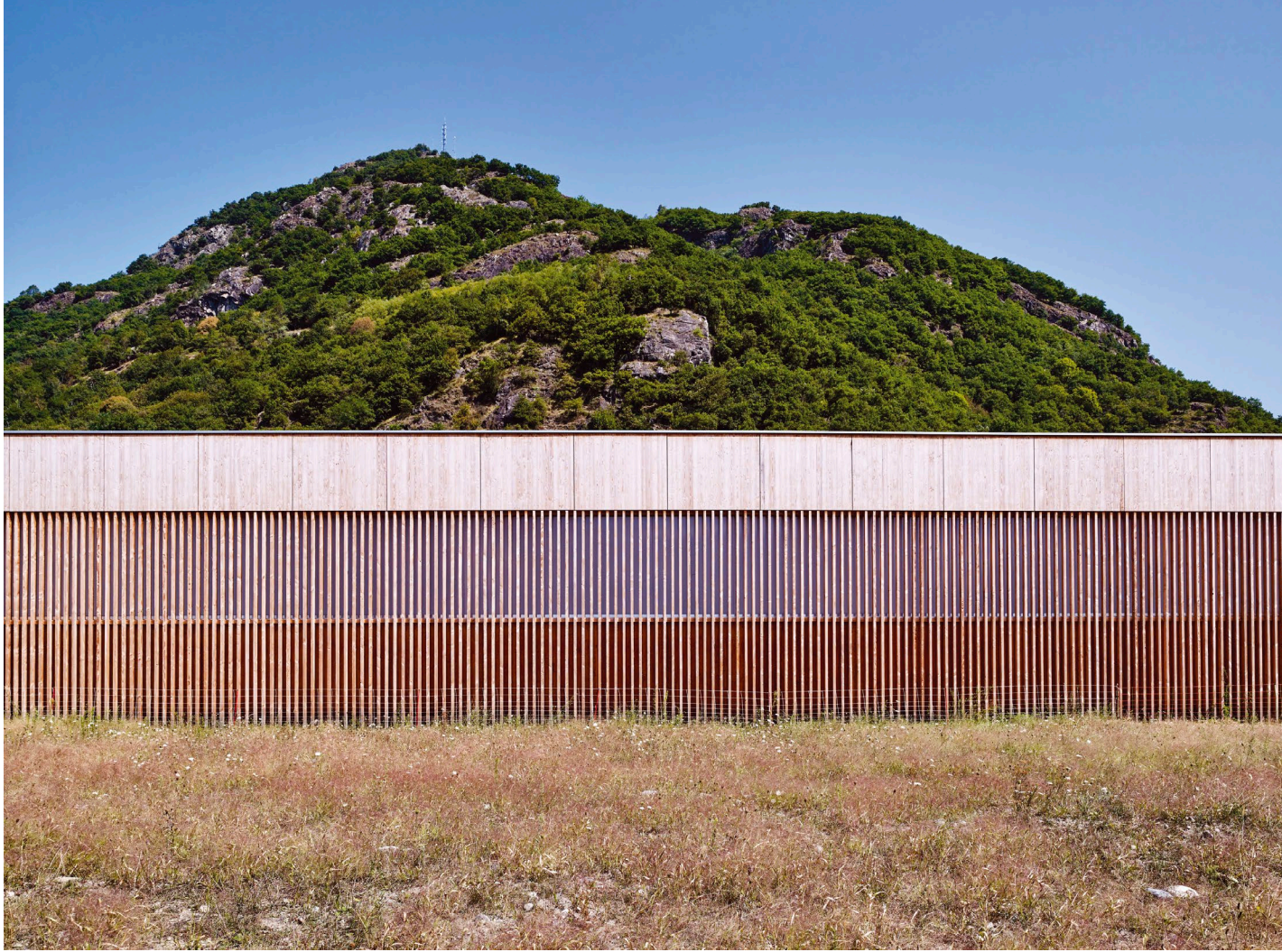
Détail du bardage de la façade Ouest
